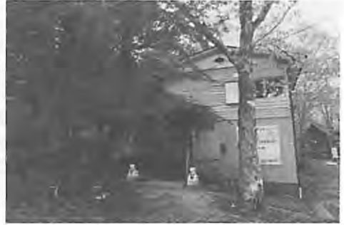
図1. 茶臼山カエル館(入口側) 調査終了後の2019年10月撮影
